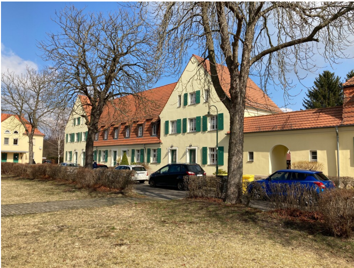
Arbeiterwohnhaus in der Gartenstadt Lauta-Nord Fotograf/Urheber: Matin Neubacher
