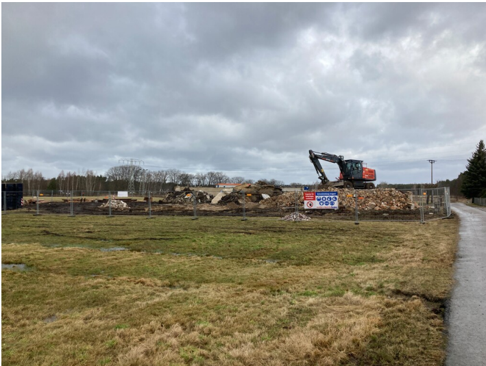
Reste eines Bauernhauses Mühlrose Fotograf/Urheber: Martin Neubacher
