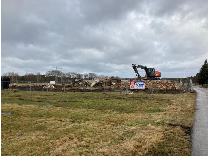
Reste eines Bauernhauses Mühlrose Fotograf/Urheber: Martin Neubacher
