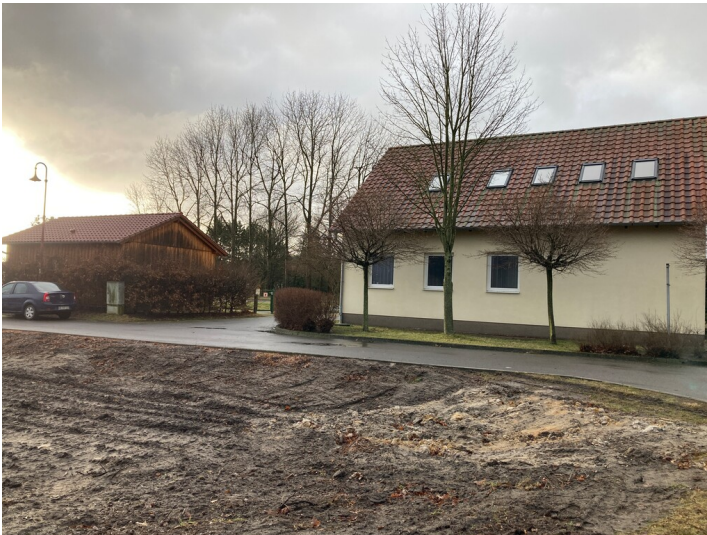
Feuerwehr Mühlrose Fotograf/Urheber: Martin Neubacher
