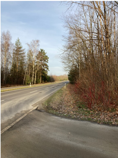
Straßendamm Halbendorfer See Fotograf/Urheber: Martin Neubacher
