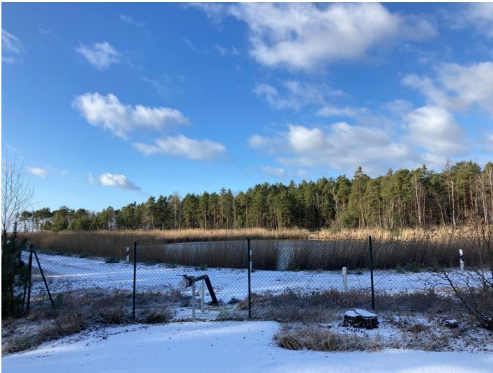
Grubenwasservorbehandlungsanlage Trebendorf Fotograf/Urheber: Martin Neubacher
