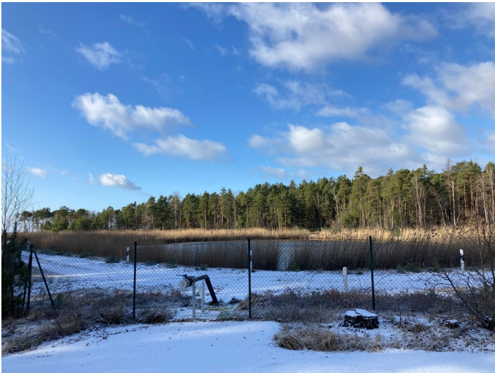
Grubenwasservorbehandlungsanlage Trebendorf Fotograf/Urheber: Martin Neubacher
