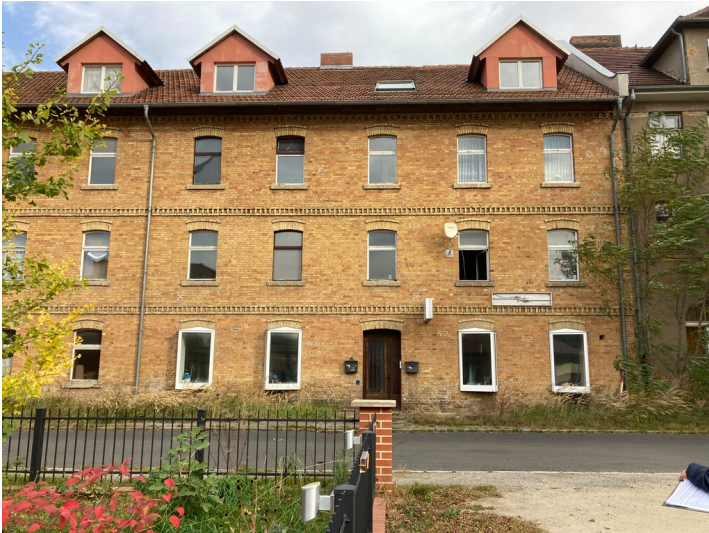
Arbeiterwohnhaus Krumme Straße 18 Fotograf/Urheber: Martin Neubacher
