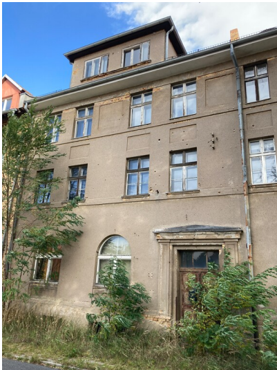
Arbeiterwohnhaus Krumme Straße 14, 16 Fotograf/Urheber: Martin Neubacher
