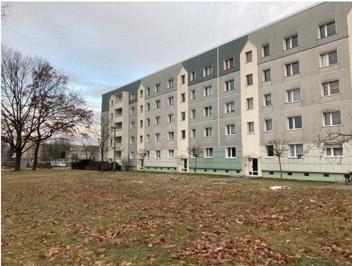
Wohnkomplex »Am Eisstadion« in Weißwasser Fotograf/Urheber: Matin Neubacher
