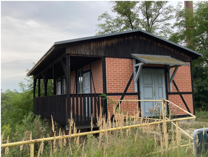
Rekonstruktion eines Steigerhauses auf dem Gelände der Brikettfabrik Knappenrode Fotograf/Urheber: Martin Neubacher
