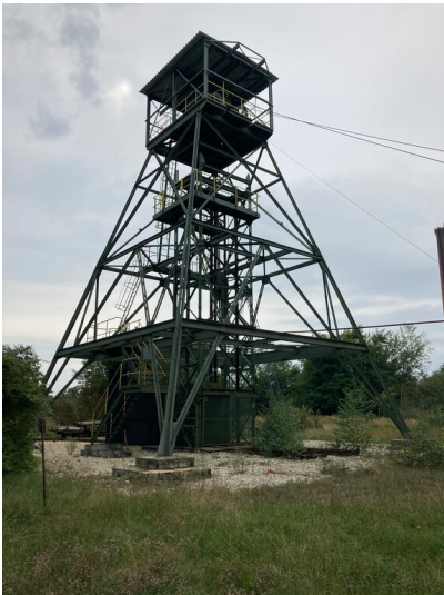
Förderturm im Gelände der Brikettfabrik Knappenrode Fotograf/Urheber: Martin Neubacher
