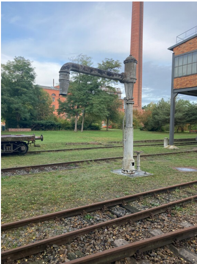
Wasserkran der Brikettfabrik Knappenrode Fotograf/Urheber: Martin Neubacher
