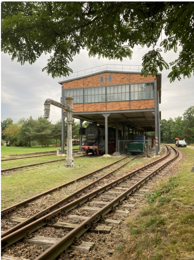
Förderkohleverladung der Brikettfabrik Knappenrode Fotograf/Urheber: Matin Neubacher
