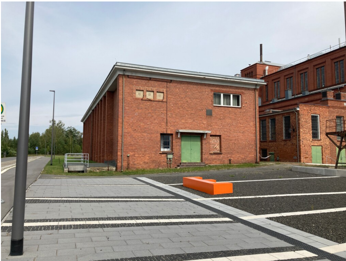
Umspannwerk; 30-kV-Station Fotograf/Urheber: Matin Neubacher
