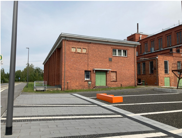
Umspannwerk; 30-kV-Station Fotograf/Urheber: Matin Neubacher
