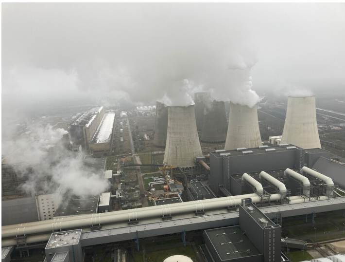
Gipslager am Block Q des Kraftwerks Boxberg, Ansicht von Osten Fotograf/Urheber: Nora Wiedemann
