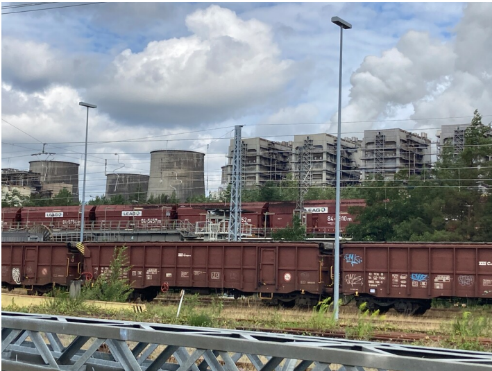
Übergabestation 6 des Kraftwerks Boxberg, Ansicht von Süden Fotograf/Urheber: Kathrin Kruner
