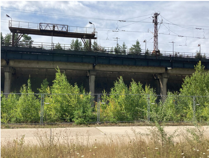
Übergabestation am Altwerk Kraftwerk Boxberg Fotograf/Urheber: Kathrin Kruner
