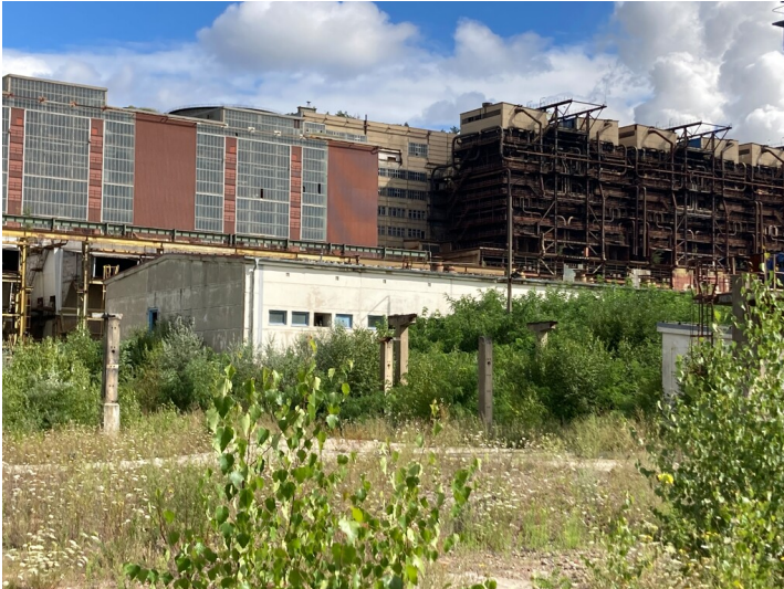
Kompressorenstation am Altwerk des Kraftwerks Boxberg, Ansicht von Süden Fotograf/Urheber: Kathrin Kruner
