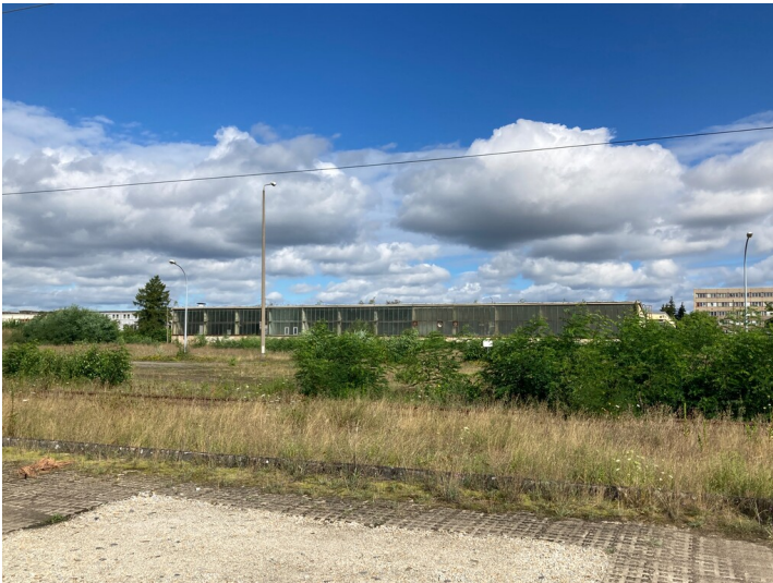
Heizöllager am Altwerk Kraftwerk Boxberg, Ansicht von Süden Fotograf/Urheber: Kathrin Kruner
