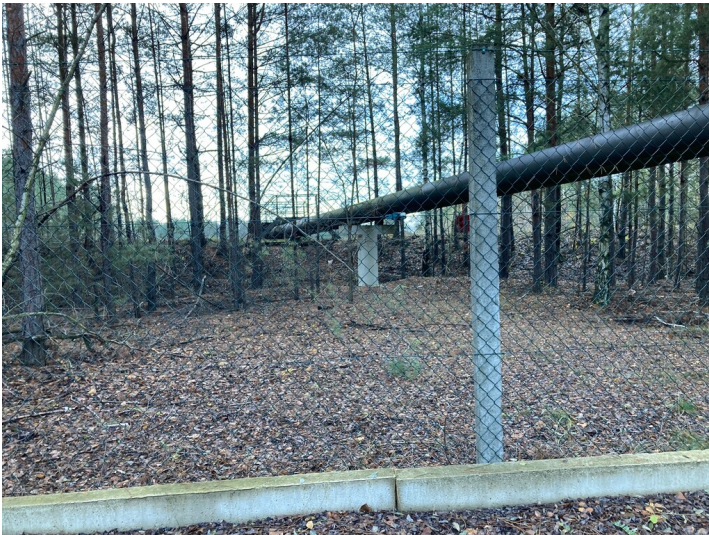
Schlammwasserbecken Altwerk Kraftwerk Boxberg, Zuleitungen Fotograf/Urheber: Matin Neubacher
