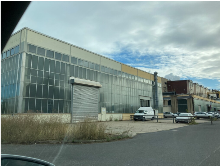
Werkstatthallen am Altwerk Kraftwerk Boxberg, Ansicht von Südosten Fotograf/Urheber: Kathrin Kruner
