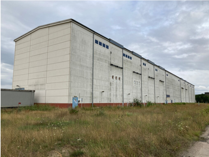
110 kV-Station am Altwerk des Kraftwerks Boxberg, Ansicht von Nordosten Fotograf/Urheber: Kathrin Kruner
