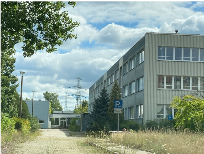
Ehemaliges Berufsschulzentrum und Lehrlingswohnheim des Kraftwerkes Boxberg, Ansicht Berufsschulzentrum von Westen Fotograf/Urheber: Kathrin Kruner
