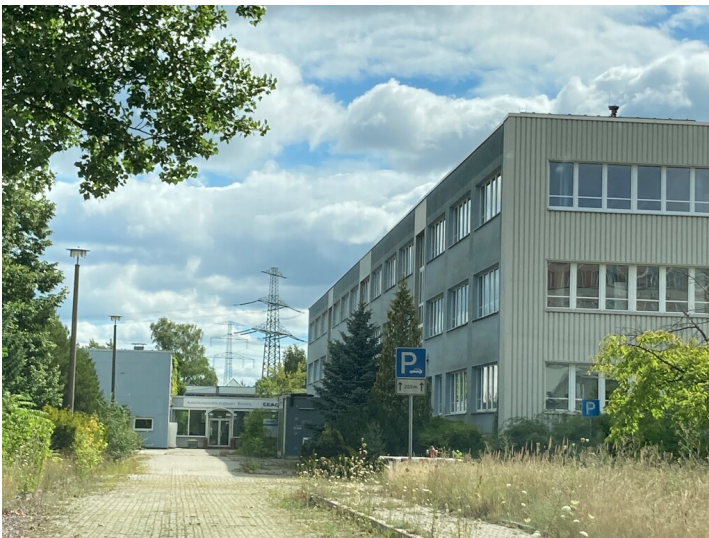
Ehemaliges Berufsschulzentrum und Lehrlingswohnheim des Kraftwerkes Boxberg, Ansicht Berufsschulzentrum von Westen Fotograf/Urheber: Kathrin Kruner
