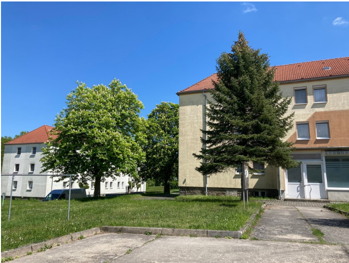
Werkssiedlung der Feuerfestwerke Wetro Fotograf/Urheber: Nora Wiedemann
