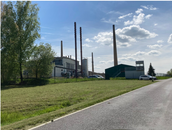
Feuerfestwerke Wetro, Ansicht von Norden Fotograf/Urheber: Nora Wiedemann
