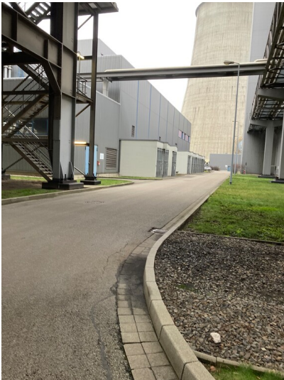
REA-Gips Lagerhalle des Kraftwerks Boxberg, Ansicht von Südosten Fotograf/Urheber: Nora Wiedemann
