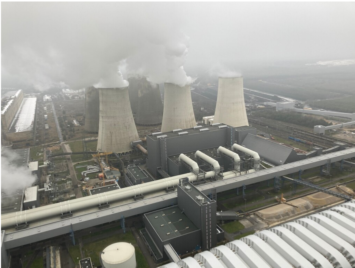
Rauchgasentschwefelung Werk III des Kraftwerks Boxberg, Ansicht von Osten Fotograf/Urheber: Nora Wiedemann
