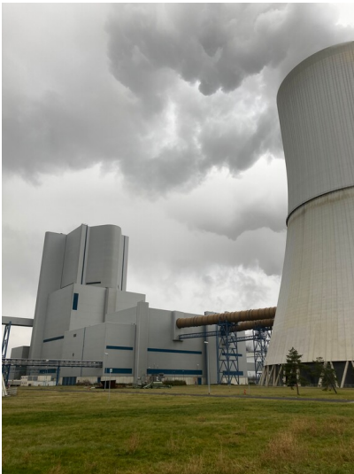
Rauchgasentschwefelungsanlage Block Q Kraftwerk Boxberg, Ansicht von Nordosten Fotograf/Urheber: Nora Wiedemann
