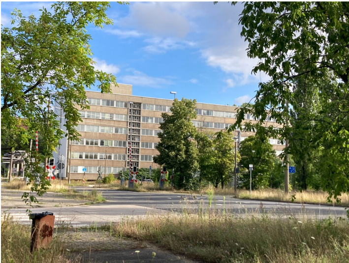
Verwaltung Altwerk des Kraftwerks Boxberg Fotograf/Urheber: Kathrin Kruner
