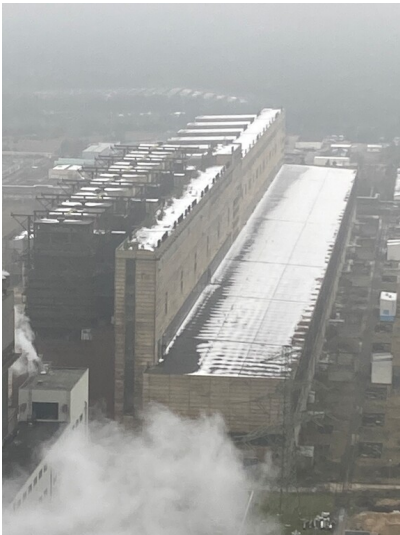
Altwerk I und II des Kraftwerks Boxberg, Ansicht Maschinenhalle von Nordosten Fotograf/Urheber: Tom Pfefferkorn
