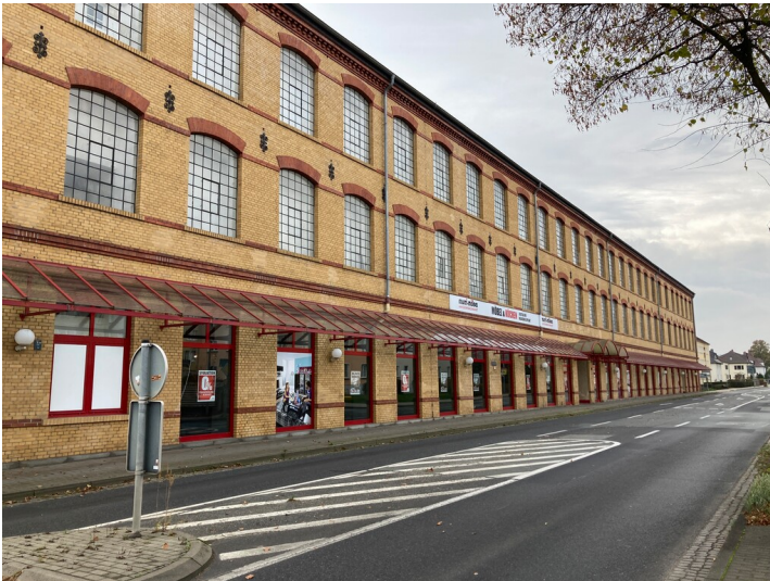
Ehemalige Textilfabrik Äußere Weberstraße Zittau, Ansicht von Nordosten Fotograf/Urheber: Kathrin Kruner
