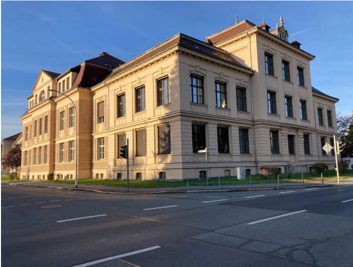
Ehemalige Fachschule für Energie Zittau, Ansicht von Osten Fotograf/Urheber: Matin Neubacher
