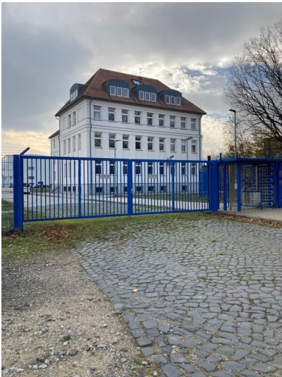
Verwaltungsgebäude des Braunkohlewerkes Hirschfelde, Ansicht von Südwesten Fotograf/Urheber: Matin Neubacher
