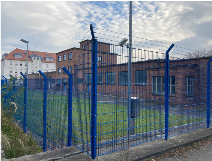
Feuerwehrdepot Braunkohlewerk Hirschfelde, Ansicht von Nordwesten Fotograf/Urheber: Matin Neubacher
