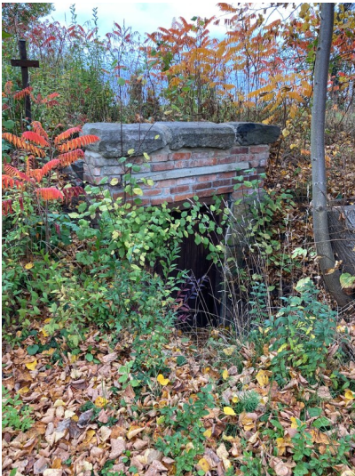
Fundamentreste Kettenbahnanlage Hartau Fotograf/Urheber: Matin Neubacher
