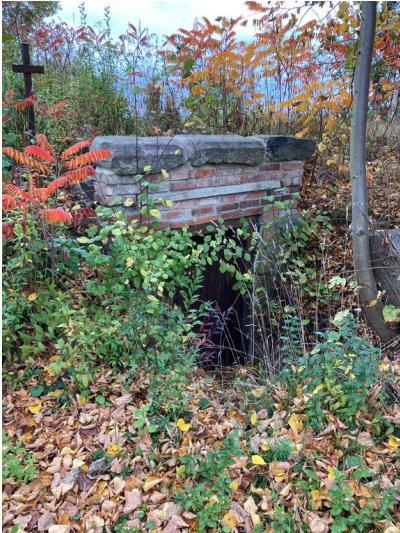
Fundamentreste Kettenbahnanlage Hartau Fotograf/Urheber: Matin Neubacher
