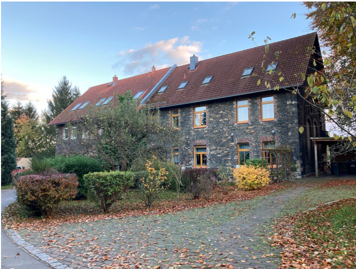
Ehemaliger Maschinenschacht II Hartau, Ansicht von Nordwesten Fotograf/Urheber: Matin Neubacher
