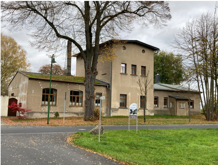
Ehemaliger Maschinenschacht I Hartau, Ansicht von Westen Fotograf/Urheber: Matin Neubacher
