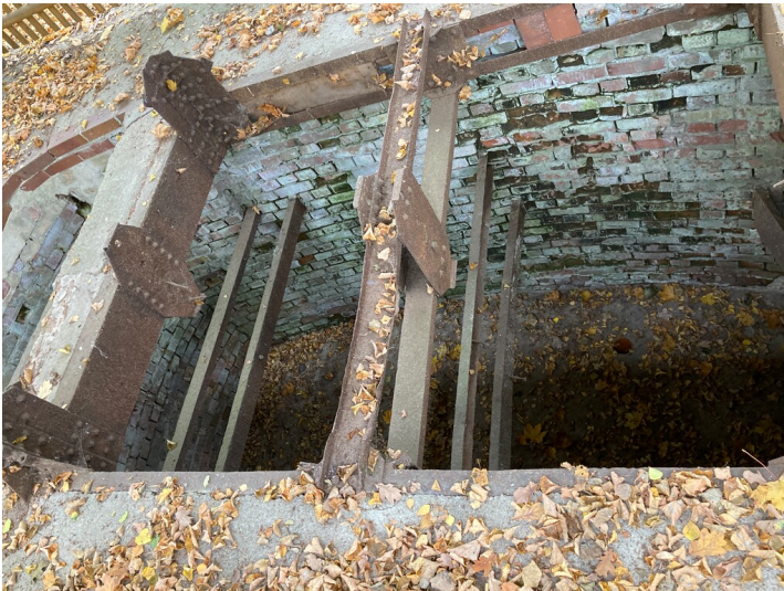
»Central-Schacht« Hartau, Blick in den Schacht Fotograf/Urheber: Matin Neubacher
