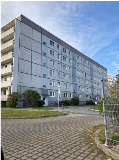
Grundbachsiedlung, Wohnblock Zum Grundbach 3 Fotograf/Urheber: Kathrin Kruner
