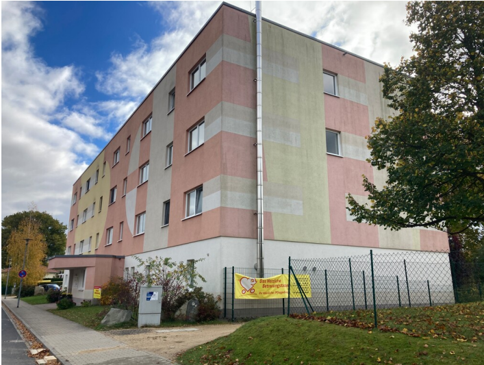
Ehemaligen Tagesanlagen des Tagebaus Olbersdorf, Ansicht Waschkaue Fotograf/Urheber: Matin Neubacher
