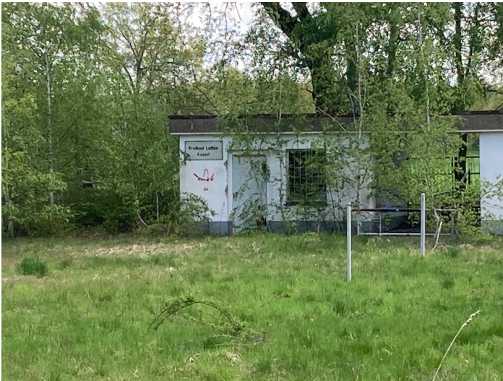
Freibad Lohsa, Ansicht Eingangsbereich von Westen Fotograf/Urheber: Martin Neubacher
