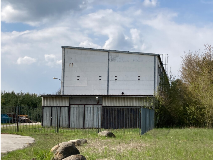
Ehemalige Tagesanlagen Scheibe, Ansicht von Osten Fotograf/Urheber: Kathrin Kruner
