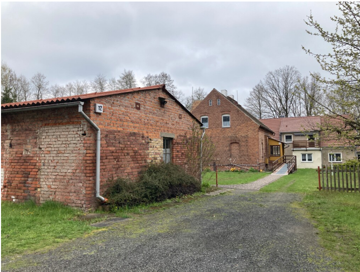
»Alte Ziegelei«, Ansicht von Süden Fotograf/Urheber: Kathrin Kruner
