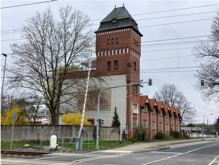
Turmgebäude mit Fassadengestaltung des Waggonbau Niesky, Ansicht von Süden Fotograf/Urheber: Kathrin Kruner
