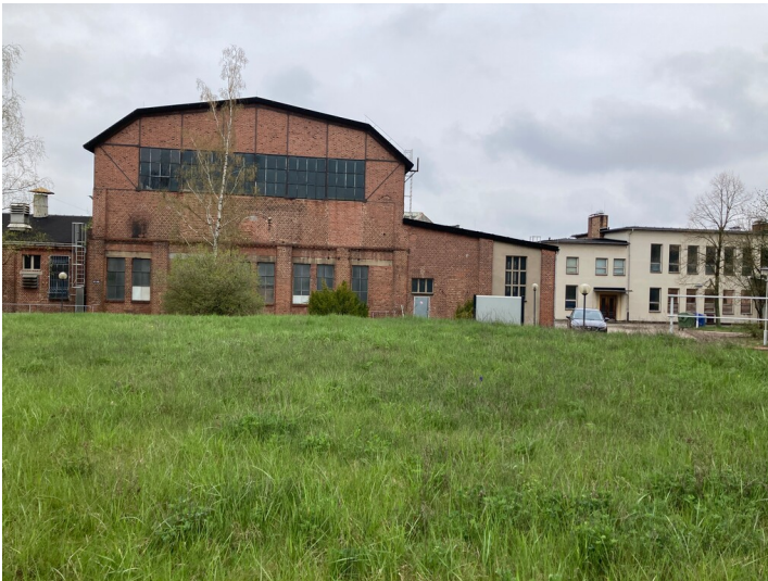
Waggonbau Niesky, Ansicht Produktionshallen von Osten Fotograf/Urheber: Kathrin Kruner
