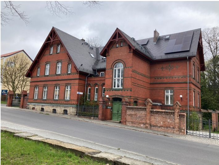
Wohnhaus von Friedrich Christoph, Ansicht von Südosten Fotograf/Urheber: Kathrin Kruner
