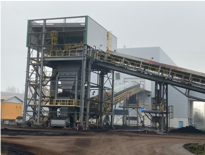
Kohleverladung des Tagebaus Nochten Fotograf/Urheber: Tom Pfefferkorn
