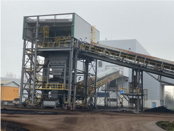
Kohleverladung des Tagebaus Nochten Fotograf/Urheber: Tom Pfefferkorn
