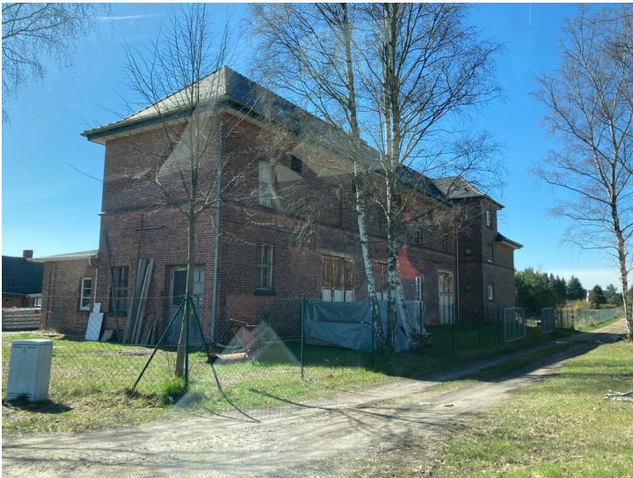
Umspannwerk, Ansicht Verwaltungsgebäude von Nordwesten Fotograf/Urheber: Kathrin Kruner
