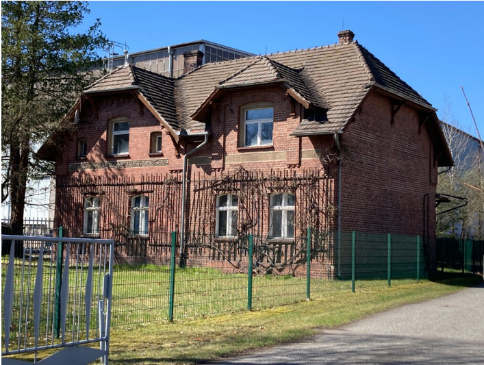
Ehemaliges Gaswerk mit Wohnhaus, Ansicht von Osten Fotograf/Urheber: Kathrin Kruner
