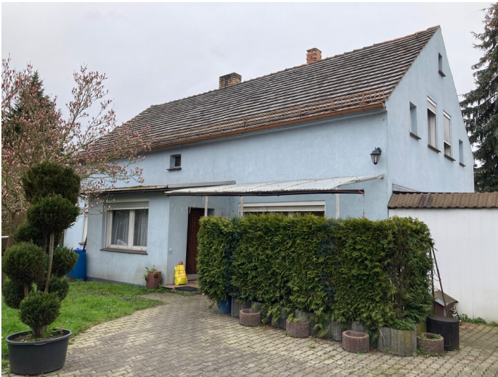
Wohngebäude der Grube Hermann, Ansicht von Osten Fotograf/Urheber: Kathrin Kruner
