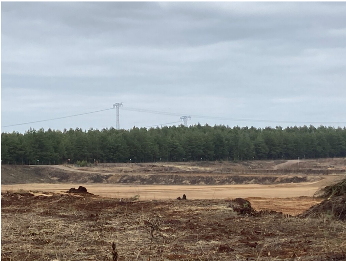
Schlammstapelbecken Kringelsdorf Fotograf/Urheber: Kathrin Kruner
