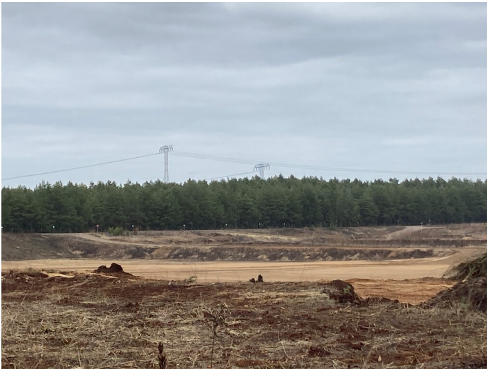
Schlammstapelbecken Kringelsdorf Fotograf/Urheber: Kathrin Kruner
